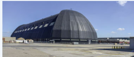
Airdock Akron/Ohio, Blick von Südwesten (Foto Roland Fuhrmann, 29. September 2013)
