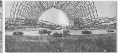
Städtische Luftschiffhalle Dresden nach Sprengung der Kuppeldrehre, August 1921 (Sprengstoff- und Munitionsgesellschaft m.b.H. Leutersdorf, in: „Berliner Illustrierte Zeitung“ vom 21. August 1921)
