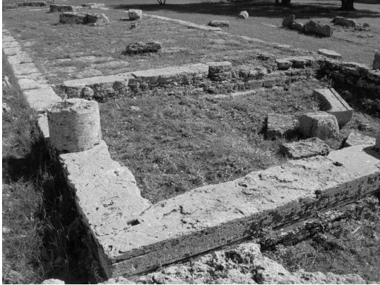
6. Paestum, Amphiprostylos, Stylobat des Opisthodomos mit Dübellöchern
