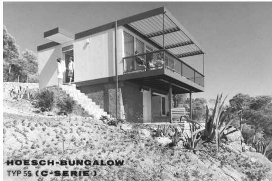
2. Hoesch ›Test-Bungalow‹, Mallorca, a Außenansicht,
