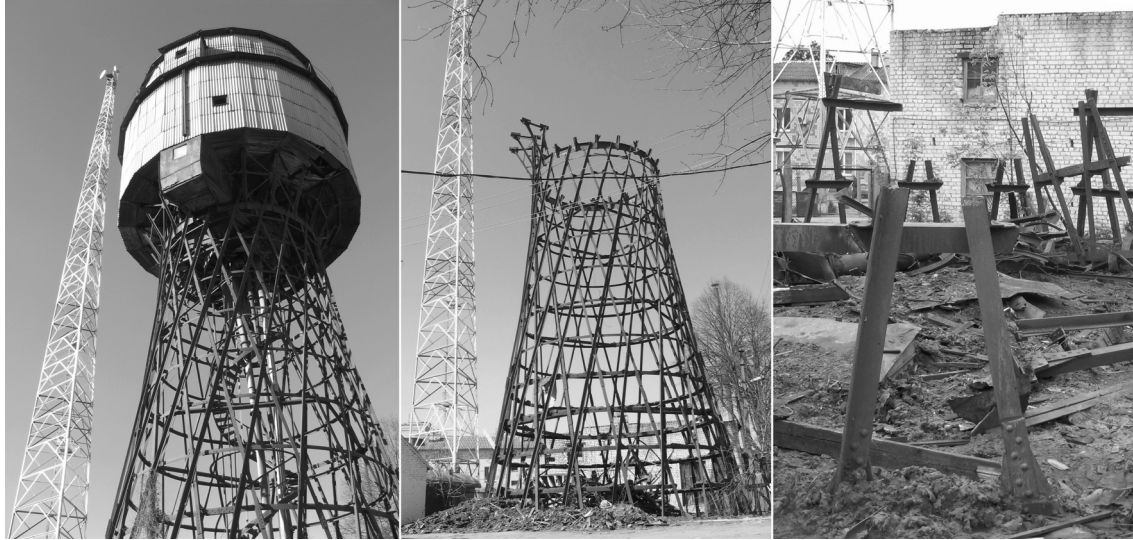
3. Wasserturm in Fastiw, Ukraine. Links: Fotoaufnahme während des ersten Besuchs im September 2011. Mitte: Fotoaufnahme November 2011 mit abgerissenem Wassertank. Rechts: März 2012, der Turm wurde bis auf die Fundamente durch eine Mannschaft mit Schweißgeräten zerstört
