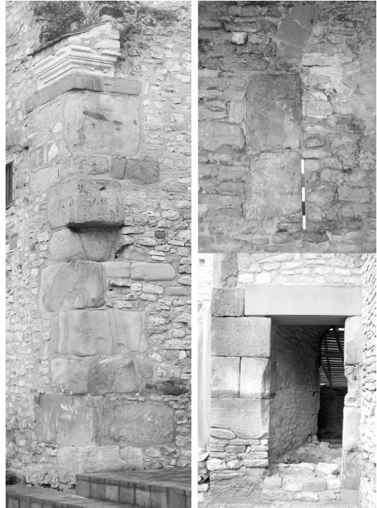
5. Spolienquader: ›Aula regia‹, Apsis, Ostecke (links), Halbkreisbau, Fenster in der Außenmauer (rechts oben), Heidesheimer Tor, südlicher Turmzugang (links unten)
