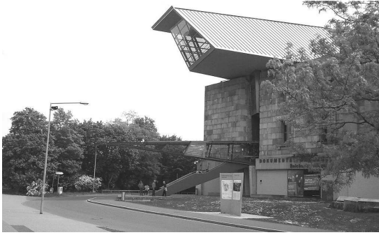
6. Das Dokumentationszentrum, Eingangsbereich. Die scharfkantige Glasbedachung der Eingangstreppe ist nur die Spitze eines den ganzen Bau durchschneidenden Erschließungsgangs
