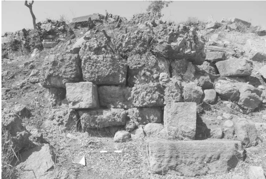
4. Südostecke aus Konglomerat mit Andesitverblendung
