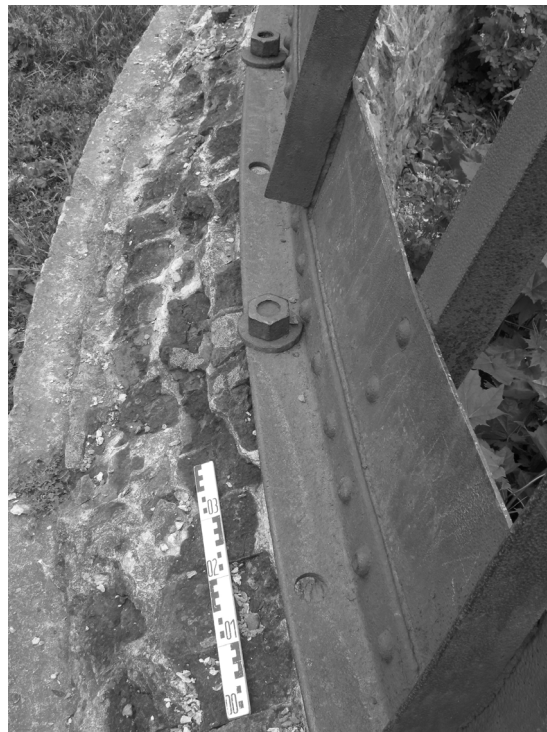
7. Fundament und Schwellenring des Turmes in Polibino
