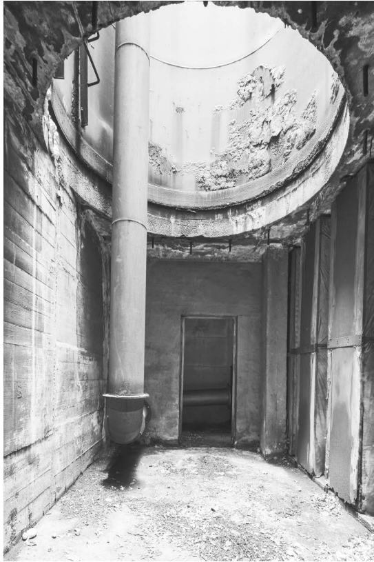
7. Institut für Kolbenmaschinen, Walter Henn 1957–65, Luftschacht unterhalb eines Ablufschornsteins
