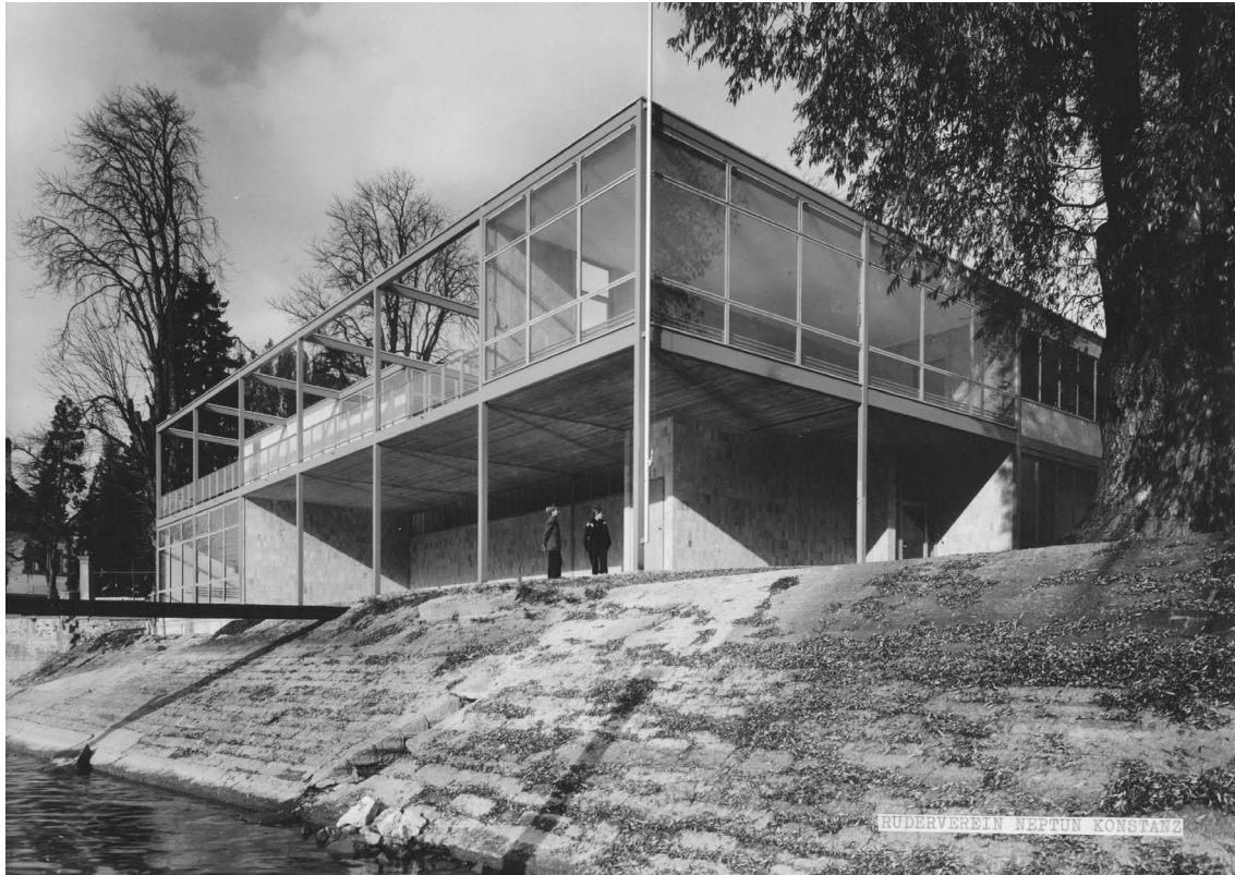
3. Ruderverein Neptun, Ansicht von Südosten, 1956, Foto Heinz Kabus
