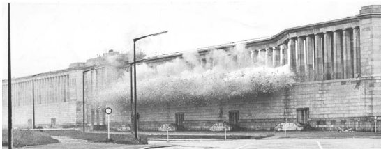
4. Sprengung der Pfeilergalerie der Zeppelintribüne
