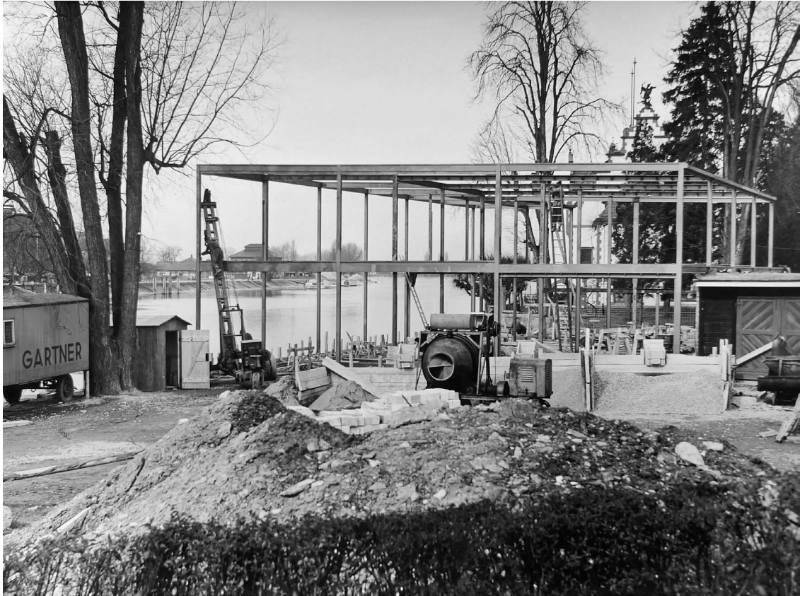
8. Ruderverein Neptun, Montage des Stahlskeletts, 1955
