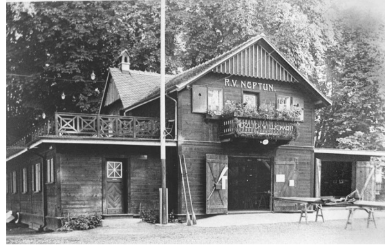
2. Ruderverein Neptun, Ansicht von Südosten, nach dem 1922 erfolgten Umbau durch Ganter & Picard mit dem älteren Bootshaus von 1894 im Zentrum. Die Bootshalle auf der rechten Seite ist bis heute erhalten
