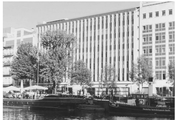
4. a) W. Würzbach – K. Bernhard, Erweiterungsbau des ADGB-Hauses, Berlin 1930–32. Baustelle (Aufnahme 1931); b) Fassade zum Märkischen Ufer (Aufnahme 2014)
