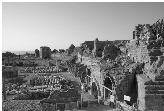
2. Abschnitte der Mauer südwestlich des Bogentors mit der Latrine, dem Bühnengebäude des Theaters, der Kurtine 3 und den Türmen 2 und 1 (von rechts nach links), 2012
