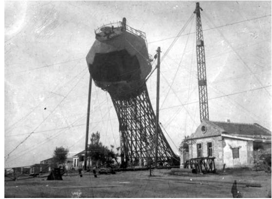
2. Arbeiten beim Wiederaufbau des Wasserturmes in Mykolajiw
