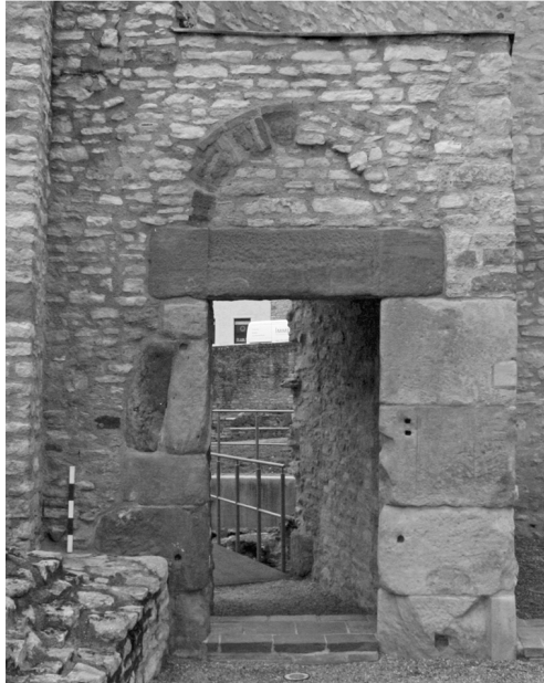
6. Türstürze mit Entlastungsbogen aus Naturstein und Ziegel. Heidesheimer Tor, nördlicher Turmzugang (links) und ›Aula regia‹, Westportal (rechts; Montage heutiger Zustand und Zeichnung Cohausen 1852). Innenansichten, Maßstab 1:50. Cohausen sah den Bogen, der profilierte Sturz wurde von ihm aufgrund von zwei Ausbruchstellen in Kämpferhöhe rekonstruiert.
