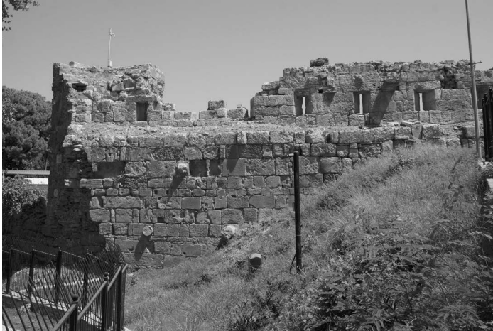
7. Stadtseitige Ansicht von Kurtine 4 und Turm 3 mit durchgehendem unterem Wehrgang und Resten der Kragplatten, auf denen der obere Wehrgang ruhte, 2015
